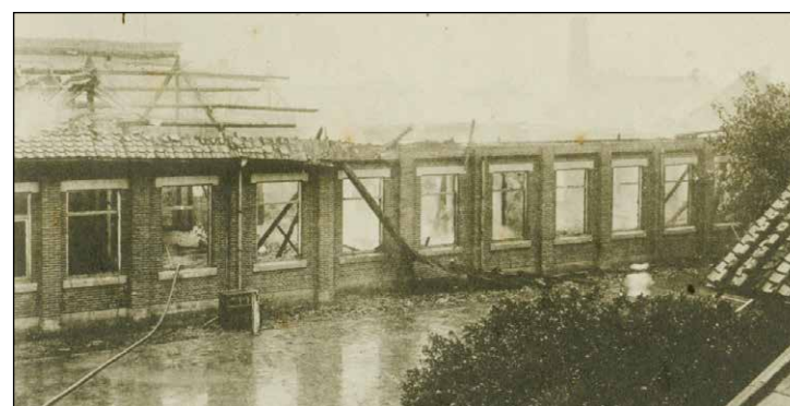
▶ 圖 14 應用化學科工場因漏電失火被燒燬情形。
