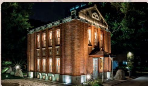
2017年5月23日 修復完工
